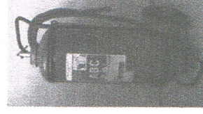
Rys. 2.63. Agregat gaśniczy proszkowy
